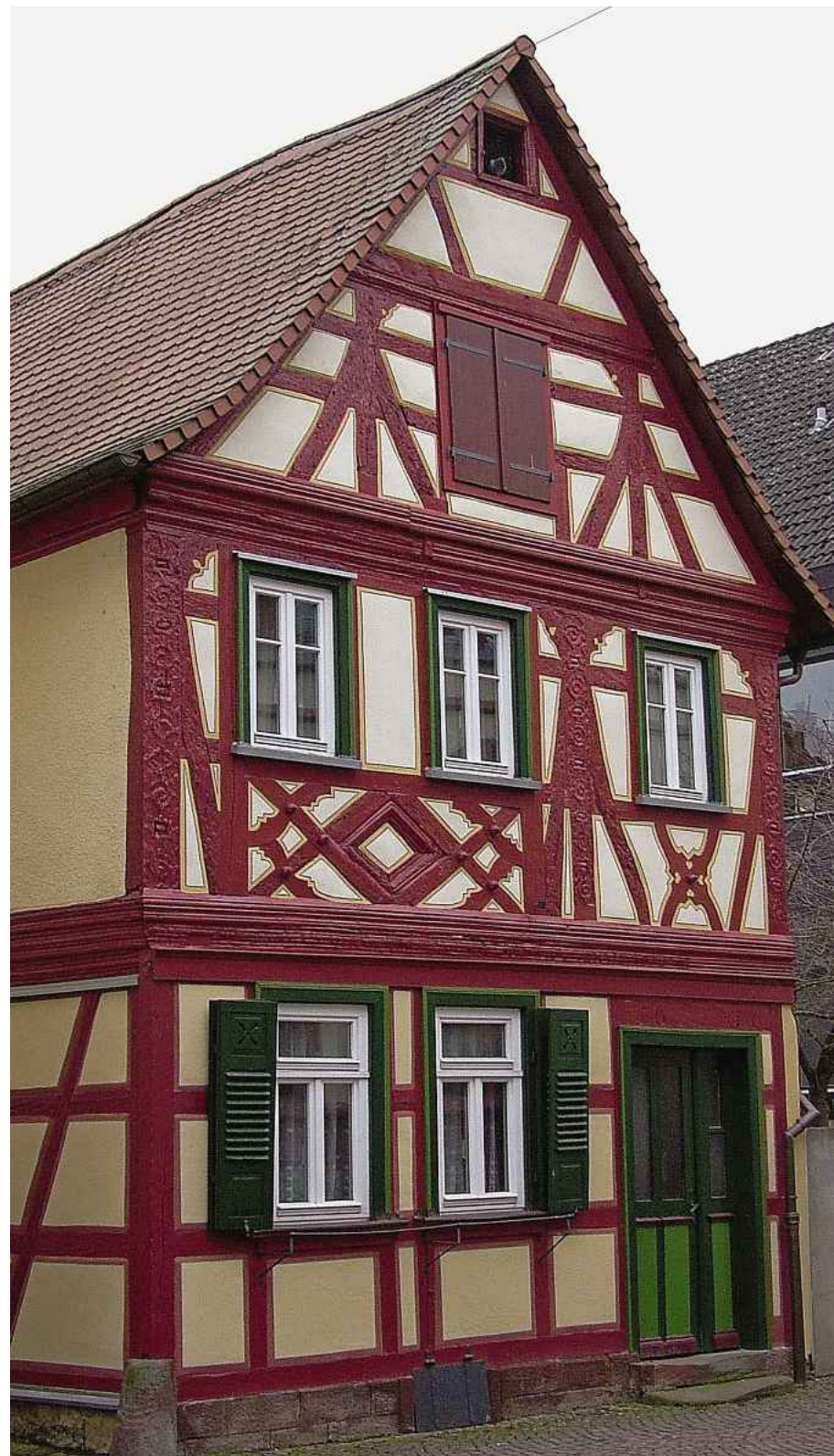
Wiederentdecktes Schmuckstück: Zwischen vielen Gebäuden aus dem 19. und 20. Jahrhundert steht das kleine Fachwerkhaus aus dem 17. Jahrhundert in der Miltenberger Hauptstraße, das die Eigentümer bis Ende vergangenen Jahres saniert haben.
