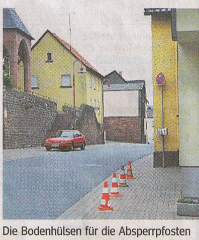
Die Bodenhülsen für die Absperrpfosten sind bereits angelegt. Foto: Helga Ackermann
