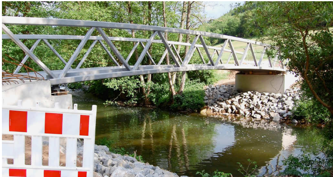
Am Donnerstag und Freitag erfolgte der »Brückenschlag« für den Erftalradweg. Noch fehlen die Anbindungen, Schutzplanken und die Feindeckschicht. Foto: Robert Ries
