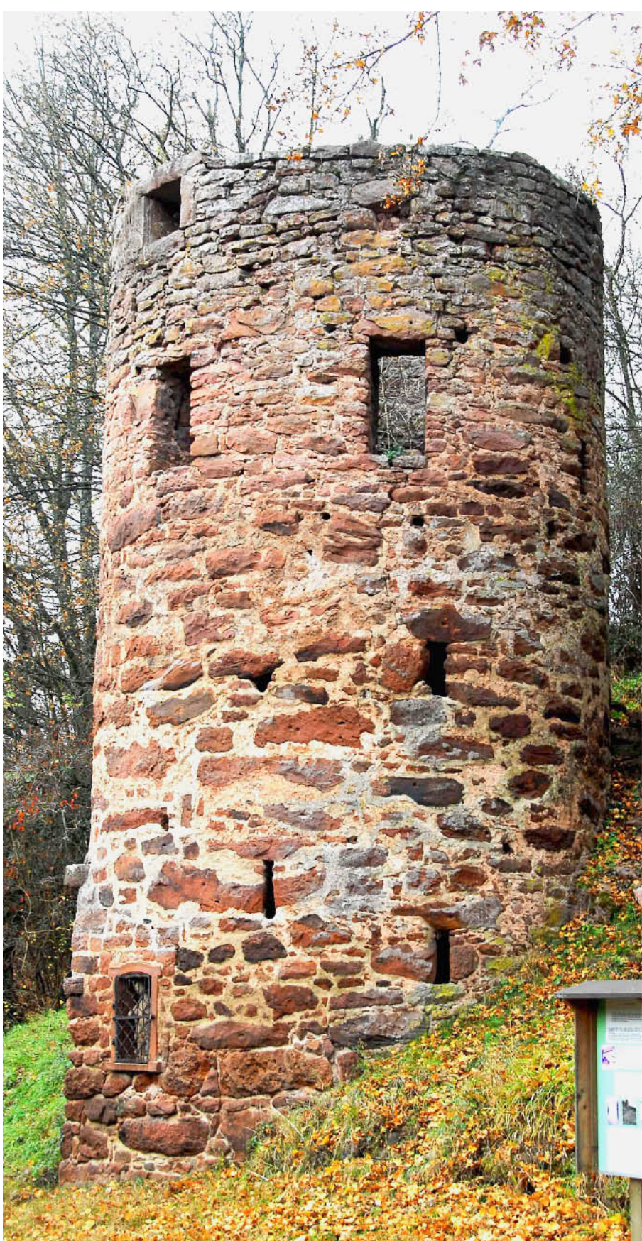
Eichenbühler Wahrzeichen: der Mautturm – um das Bauwerk zu erhalten, steht jetzt eine Sanierung an.
