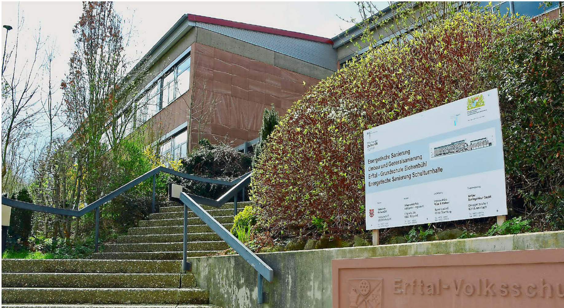
Umbau und Generalsanierung der Ertal-Volksschule in Eichenbühl sorgen nach wie vor dafür, dass im gemeindlichen Vermögenshaushalt 2012 erhebliche Mittel bereitgestellt werden müssen. Die Generalsanierung soll bis Frühjahr 2013 laufen. Dagegen sollen der Kindergarten und die Kinderkrippe bereits im September 2012 ihren Betrieb aufnehmen. Foto: Winfried Zang
