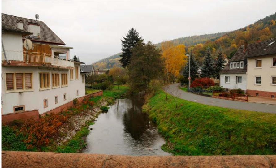
An der Halbmondbücke müsste die Straße rechts um einen Meter angehoben werden, um die Häuser dahinter vor Hochwasser zu schützen. Am Haus links müssten die tiefliegenden Fenster geschlossen und die Wand verstärkt werden.
