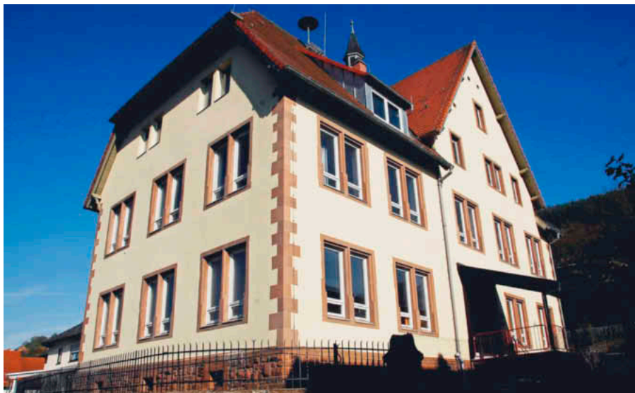
Die alte Volksschule ist eines der Wahrzeichen der Erftalgemeinde. Der energetische Zustand bereitet dem Gemeinderat Bauchschmerzen. Vor einer Sanierung muss jedoch zunächst über ein Nutzungskonzept nachgedacht werden.
