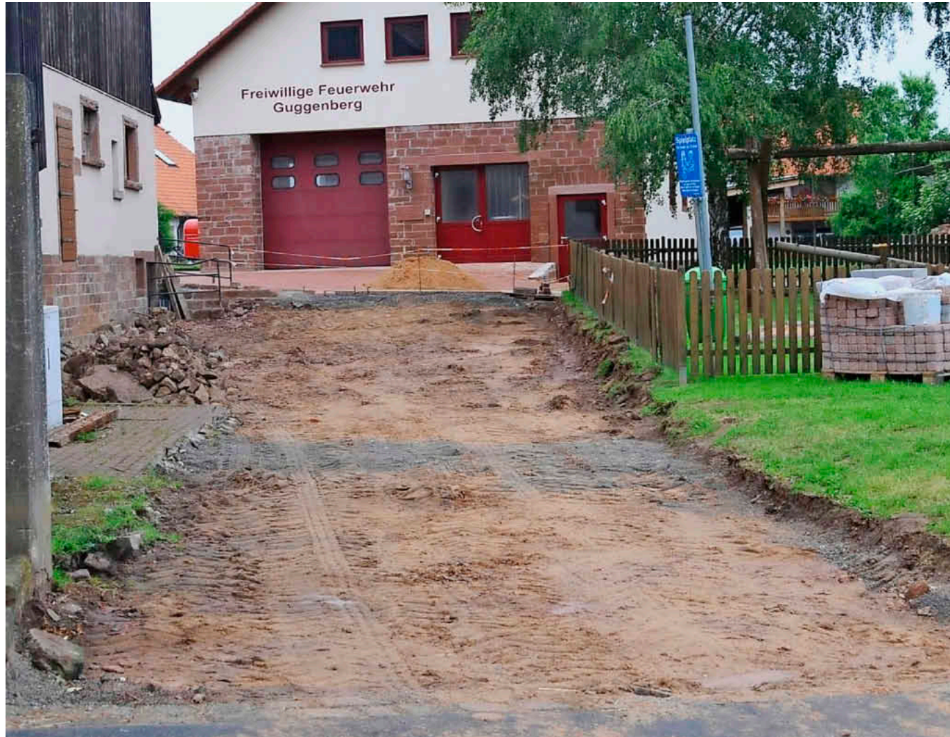
Gesprächsstoff: Das alte Pflaster vor dem Feuerwehrhaus hat der Käufer in einer Nacht- und Nebelaktion abgeholt.
