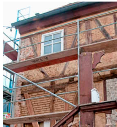
Lehmputz und Lehmsteine wurden nach alter Technik bei der Restaurierung erneuert.
