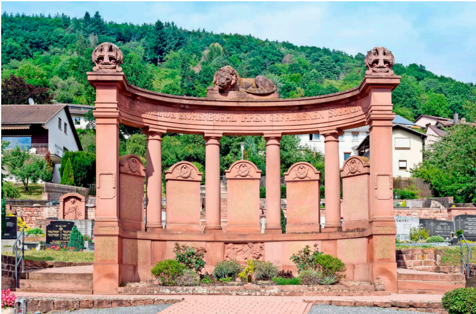
Eindrucksvoll: Das Eichenbühler Kriegerdenkmal ist ohne Zweifel das eindrucksvollste und zugleich größte Denkmal in der Region. Es ist eines der 15 Denkmäler, die unter Denkmalschutz stehen. Foto: Bernd Ullrich
