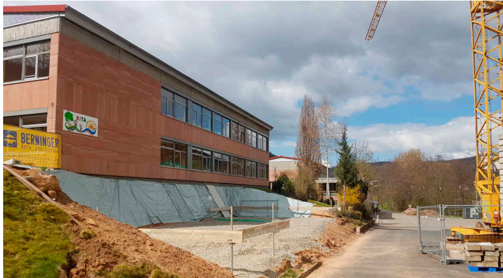
Die Erdarbeiten am Erweiterungsbau der Eichenbühler Kita sind abgeschlossen. Noch in dieser Woche sollten die Maurer- und Betonarbeiten beginnen. Foto: Siegmар Ackermann
