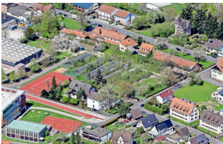
Auf einem alten Gärtnereigelände (Bildmitte), direkt am Amorbacher Schulzentrum wird das neue Gesundheitszentrum entstehen. Foto: Axel Häsler
