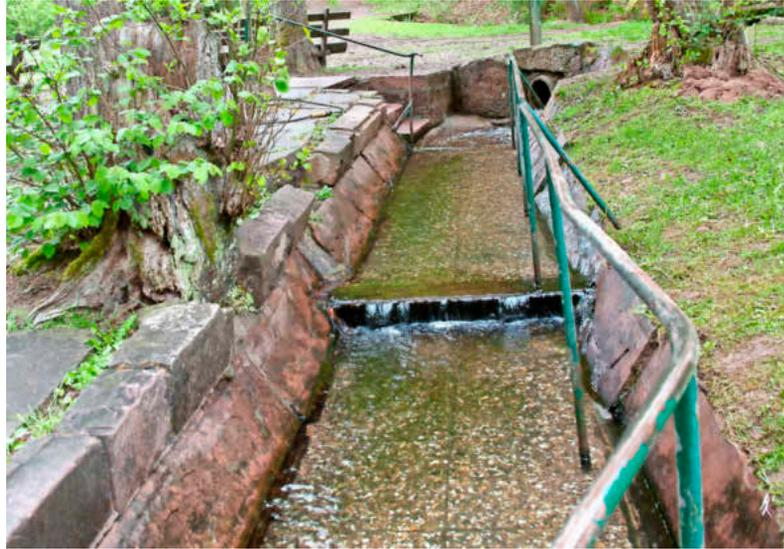
Sandsteinen, die hauptsächlich durch den Wurzeleinwuchs des Baumbestandes beschädigt wurden. Des Weiteren soll ein neues Geländer angebracht werden. Die für diese Maßnahmen notwendigen Investitionen wurden mit 10000 Euro veranschlagt, die vor-
